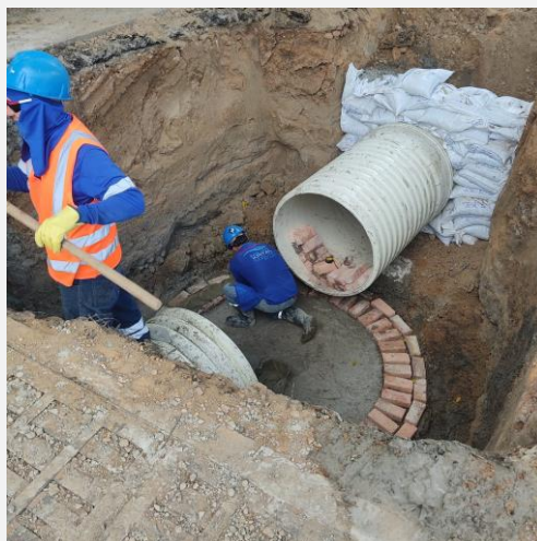
Reposición Alcantarillado 39" Avenida Guaimaral Canal Bogotá a Calle 11AN
