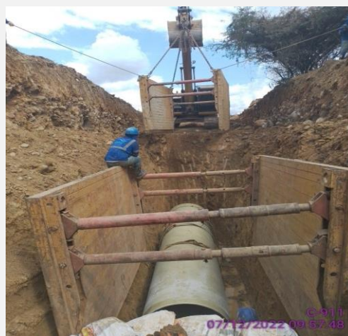
PANC, Reposición línea acueducto Pórtico - Estación Santander fase II
