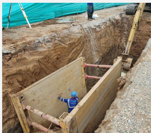
Reposición Alcantarillado PSMV, Interceptores Izquierdo Y Derecho - Canal Bogotá - Fase I Tramo Parque Lineal
