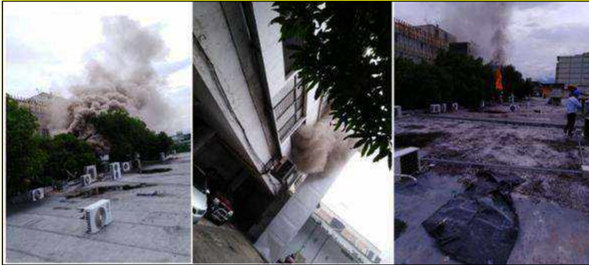
Incendio presentado en uno de los restaurantes ubicados en el primer piso del edificio San José – Sede Principal de AKC S.A. E.S.P. (Sede Administrativa)– 2018-10-25.
