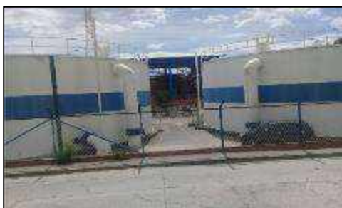
Tanque Loma de Bolívar I y II
